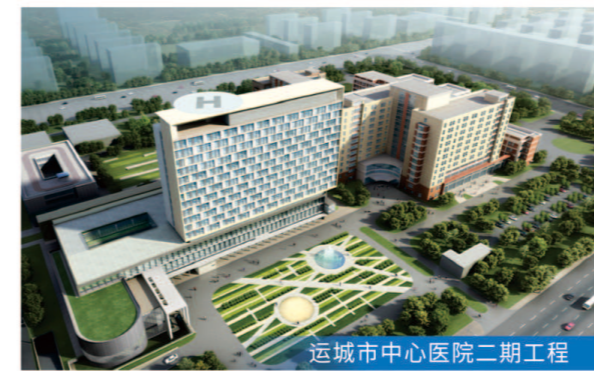
运城市中心医院二期工程
