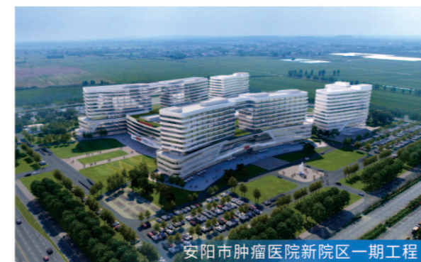
安阳市肿瘤医院新院区一期工程
