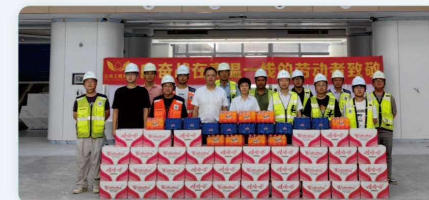
7月31日，集团副总经理、工会主席杨爱东赴绍兴市人民医院镜湖总院建设项目走访慰问项目部同事。
